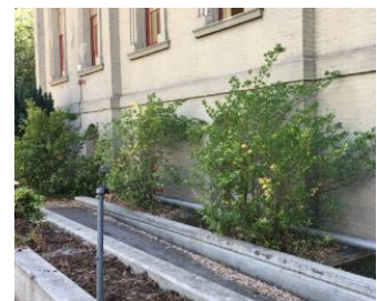
Fire suppression retrofit
